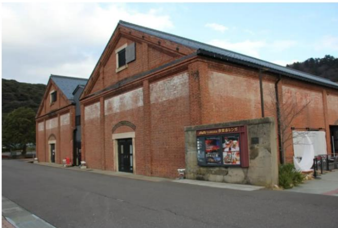
敦賀赤レンガ倉庫
