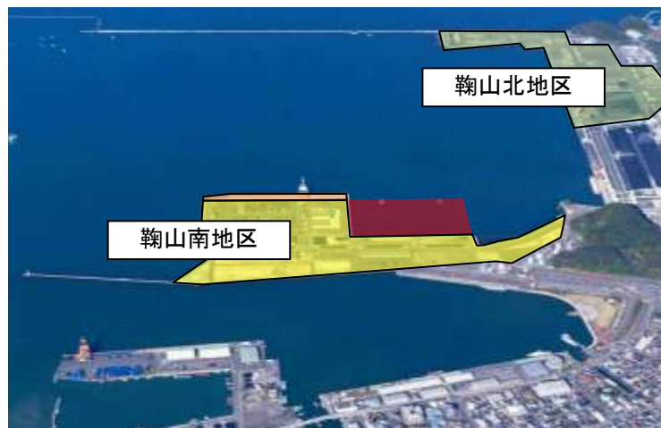
敦賀港鞠山南地区多目的国際ターミナル(敦賀市)
