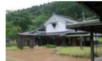
道の駅「若狭熊川宿」の改修整備
