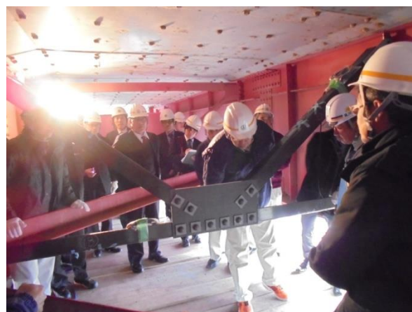
試作したCFRP部材を使った道路橋への国内初の試験施工と実証試験 (清間橋(あわら市))
