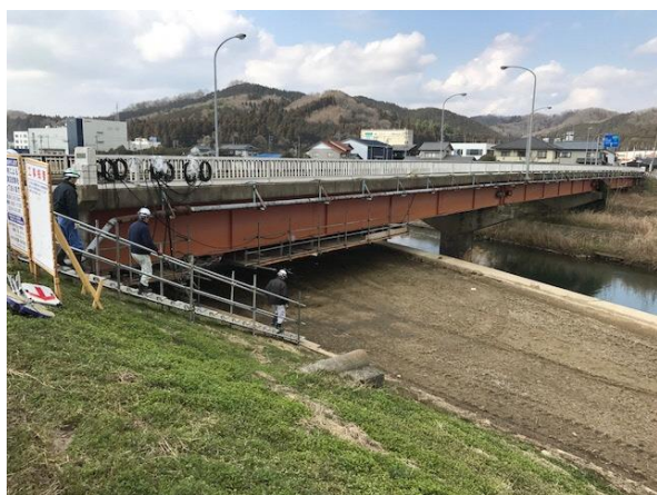
試作したCFRP部材を使った道路橋への国内初の試験施工と実証試験 (清間橋(あわら市))
