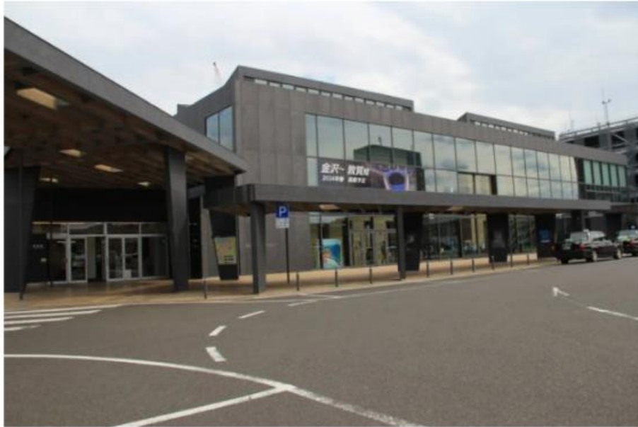
敦賀駅（福井県敦賀市）
