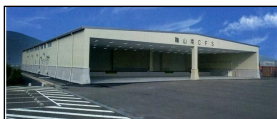
敦賀県営CFS (平成25年11月竣工) ・鉄骨造平屋 ・荷捌きスペース約2,600㎡
