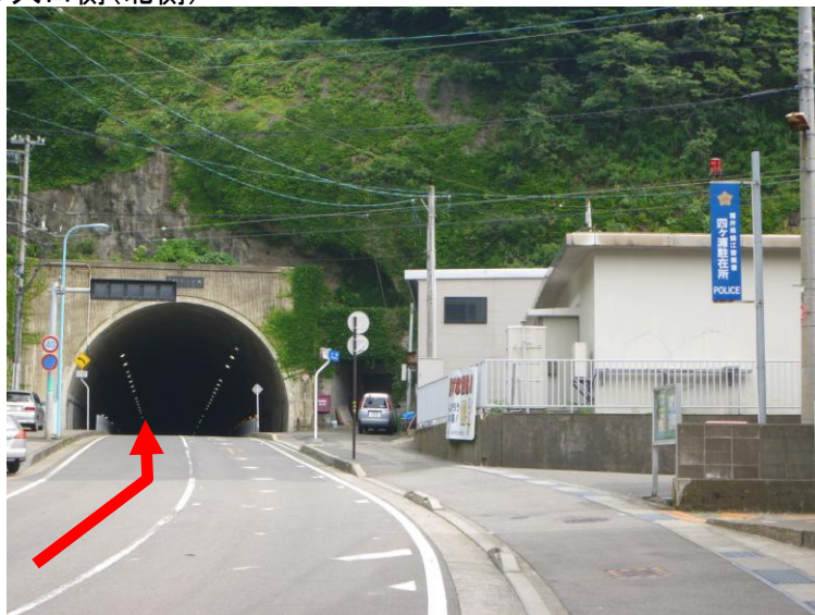
①トンネル入口側(北側)
