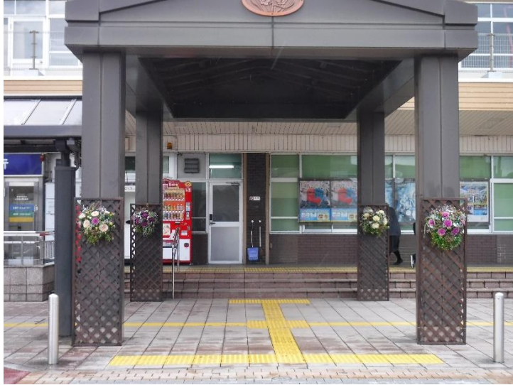
【写真1】 JR武生駅正面入口付近
