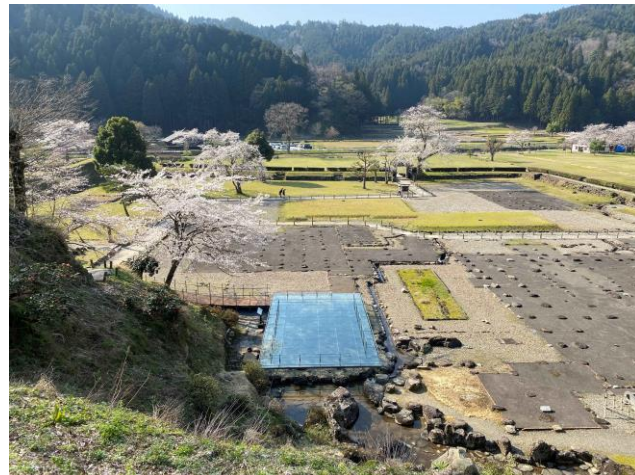
写真6 令和4年度施工完了状況（泉殿跡とスロープ）
