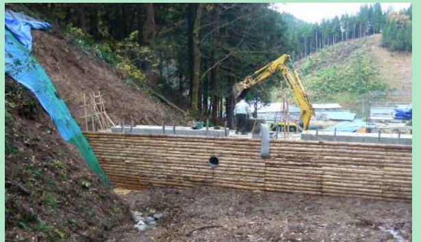
治山ダム工施工状況
