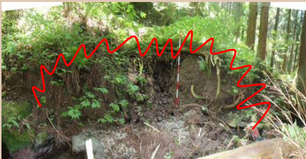
溪岸浸食状況
