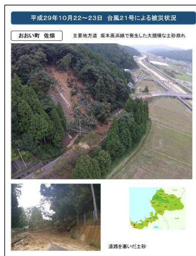
台風による土砂崩れ
