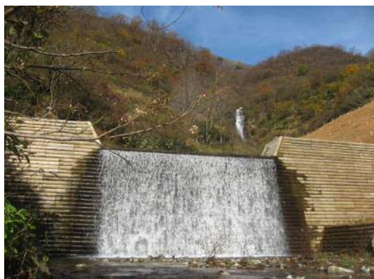
勝山市野向町横倉 （治山ダム工）
