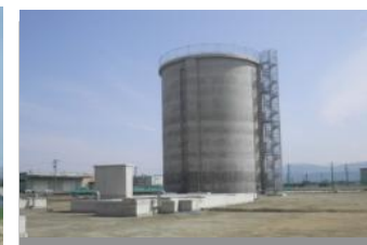
春江北部調圧水槽
