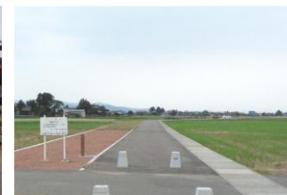
パイプライン埋設後
