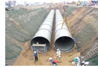
右岸幹線用水路 (強化プラスチック複合管： 口径2,800mm×2条)
