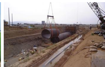
パイプラインの埋設 (鋼管：口径3,500mm)
