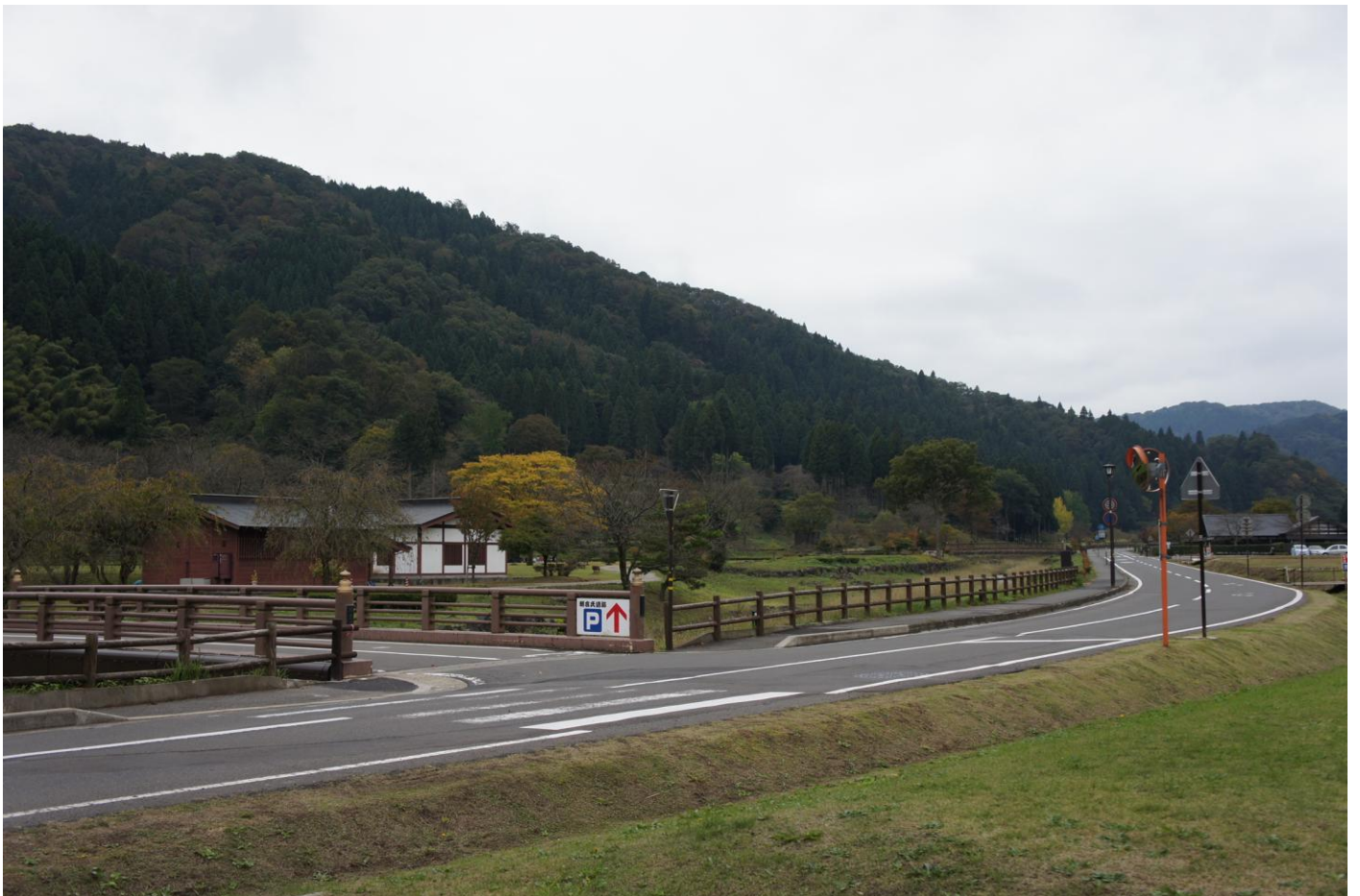
電線電柱撤去後
