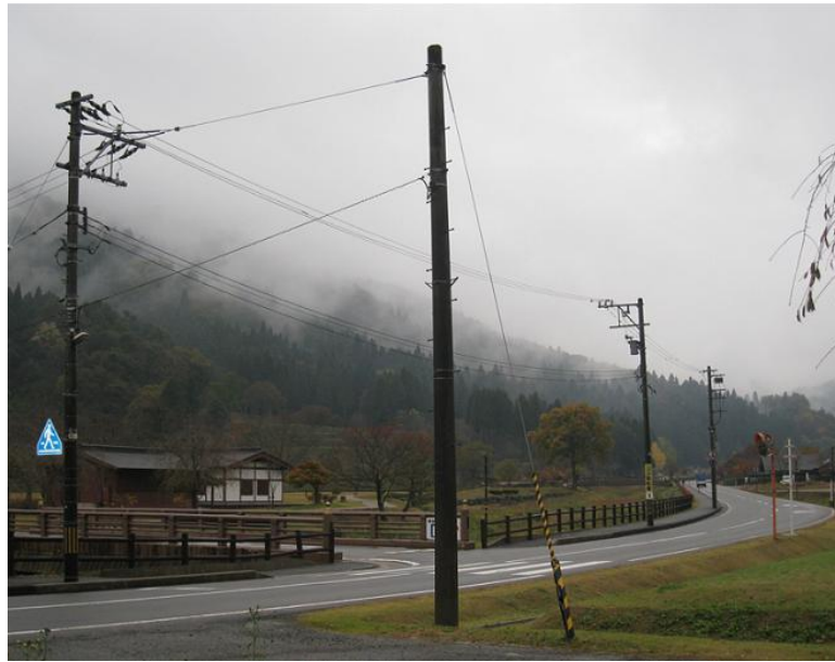
電線電柱撤去前
