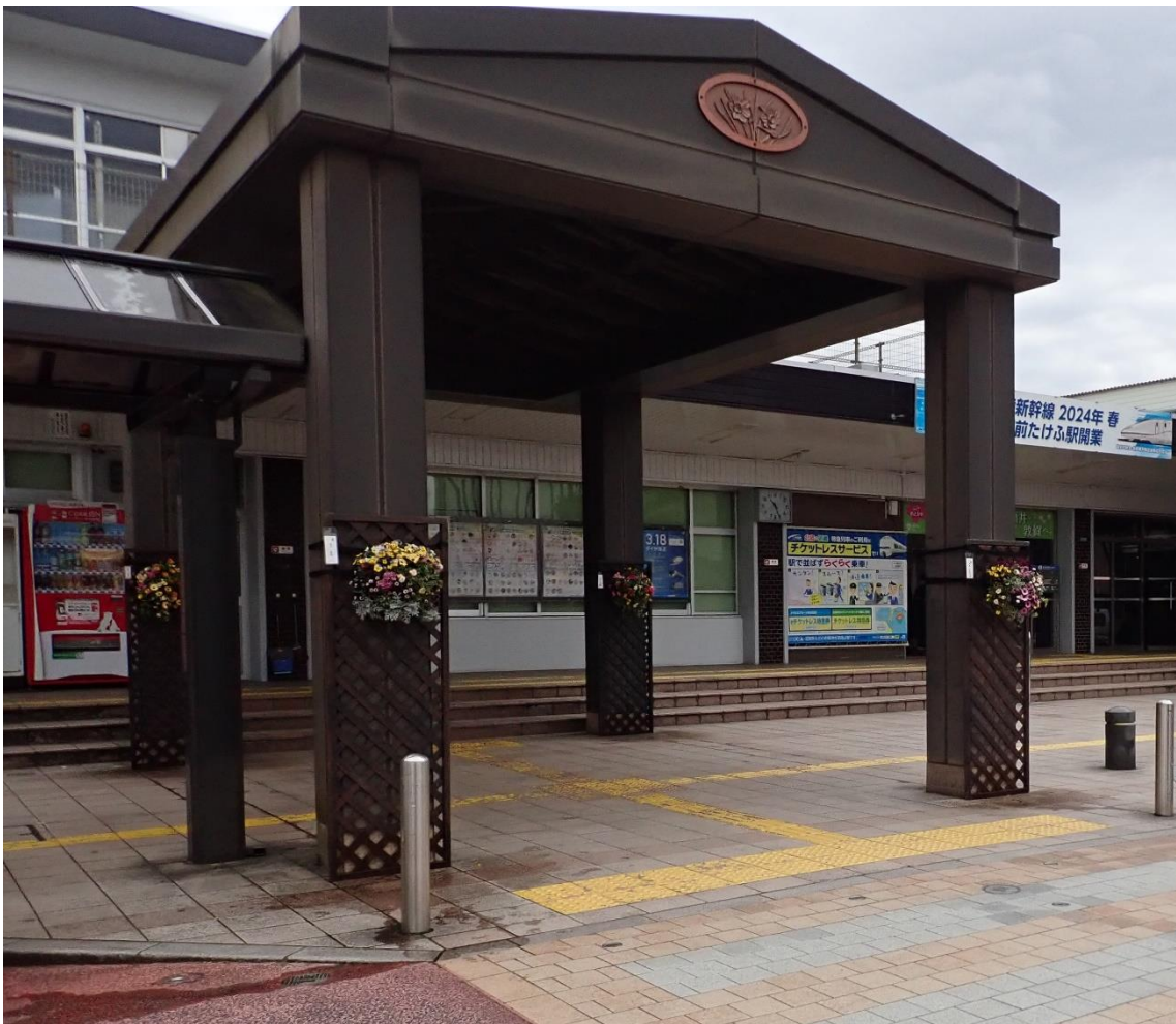
図1. ハンギングバスケット設置予定位置 駅向かって左側（令和4年度設置写真）
