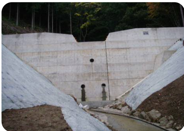
三方上中郡若狭町有田 （治山ダム工）
