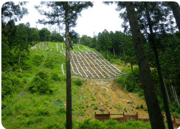
あわら市清滝 （山腹工）
