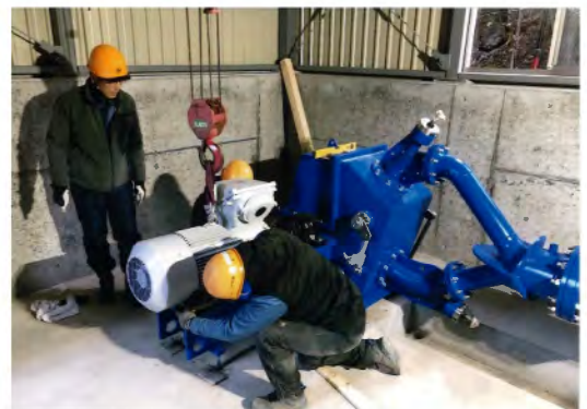
【発電機の設置】
