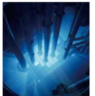
表紙の写真は、電気を帯びた電子や陽子(荷電粒子)が水中の光の速さより早い速度で進む時に発生する青白い光(チェレンコフ光)で、原子炉を運転した時などに見られる現象です。
