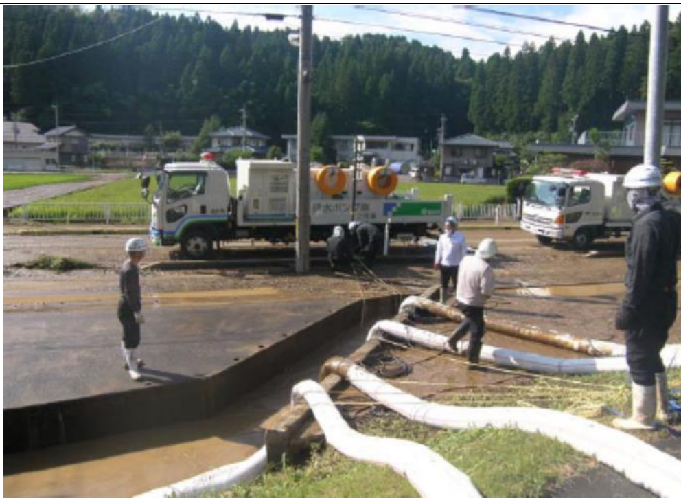
破堤箇所からの排水中
