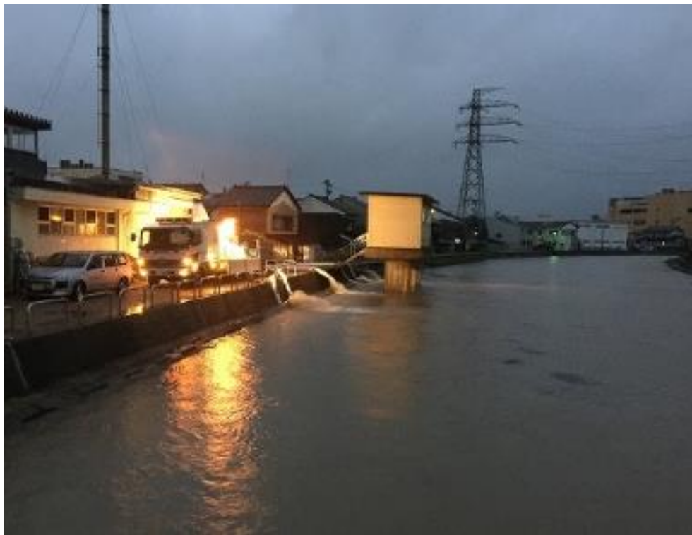
荒川へ排水作業中
