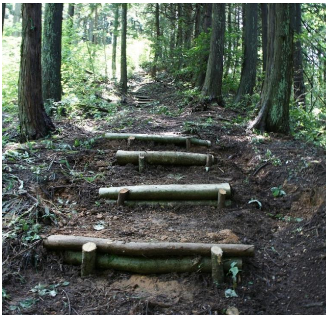
三万谷ルート階段整備
