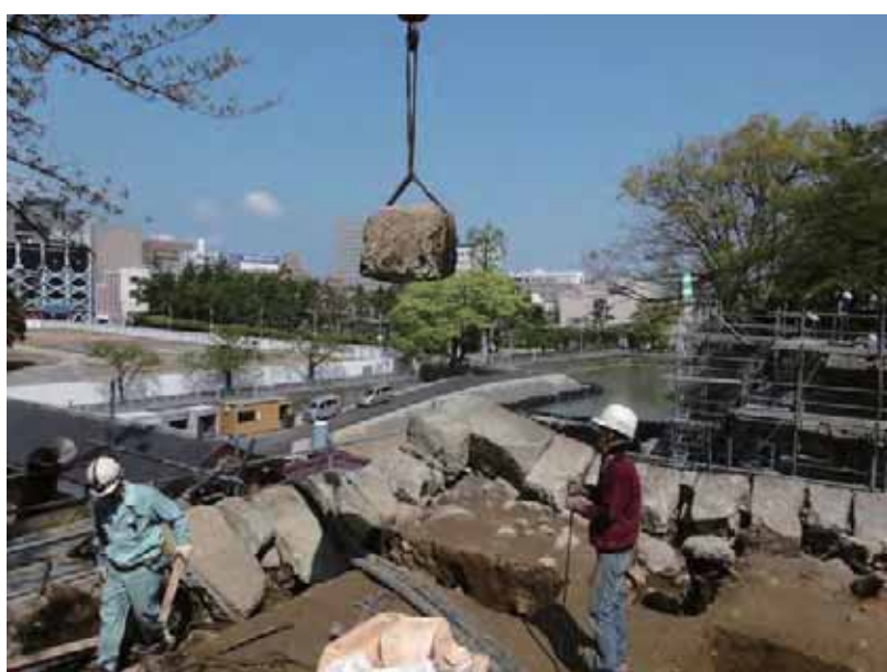
石垣は1石ずつ解体
