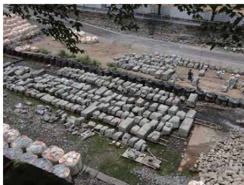
解体した石は作業ヤードで保管
