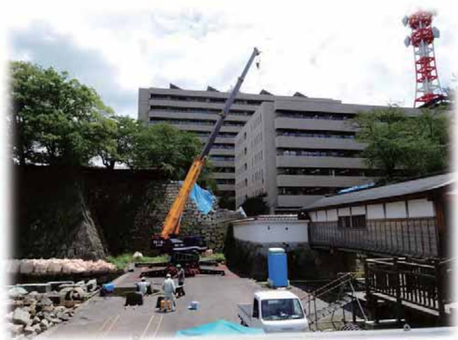
石垣解体の作業状況（中央公園側から）
