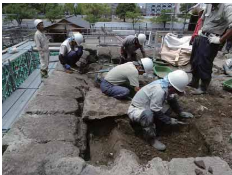
手掘りで石垣背面盛土を掘削
