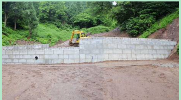
治山ダム工施工状況
