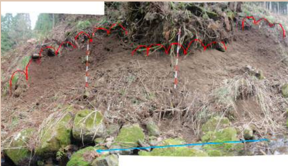
溪岸浸食状況
