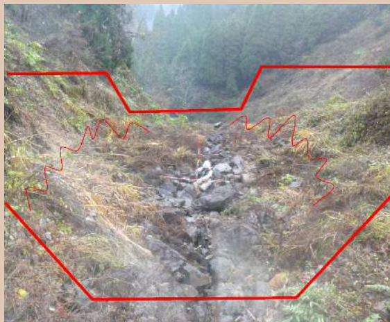
治山ダム工着工前状況
