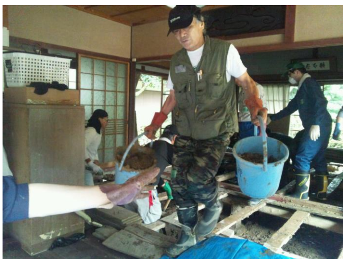
床下の土砂をバケツリレーで運び出す(28日)
