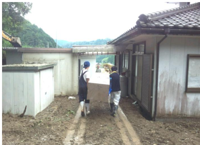
濡れた家財を住宅から運び出す(22日)
