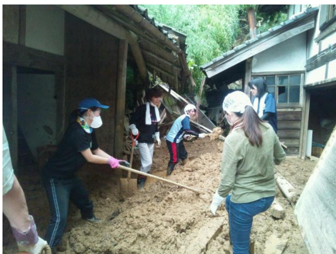
住宅の庭に流れ込んだ土砂の撤去(24日)
