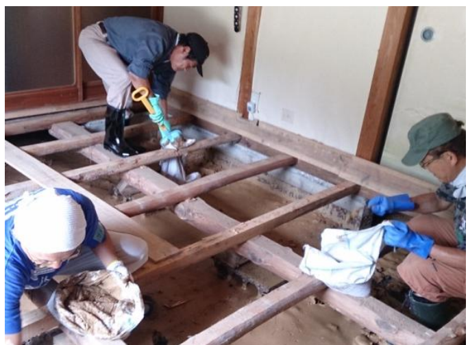
床下浸水した住宅の泥上げ作業(23日)
