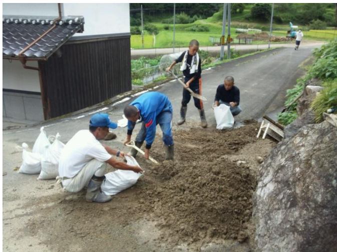
住宅周辺の土砂清掃(22日)
