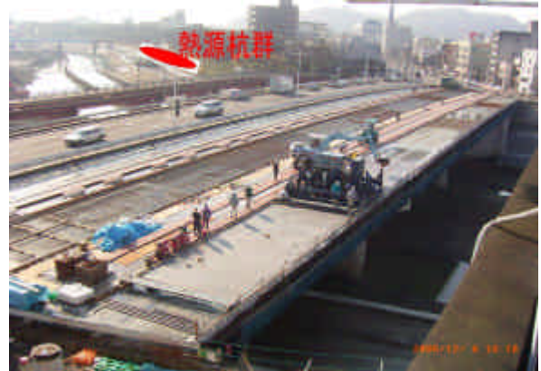
鋼繊維補強床版・舗装の施工 2006.12.6
