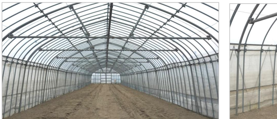
間口 5.4m、P径 25.4 mm、ピッチ 45 cm、P径 42.7 mmのアーチ+タイバー補強
