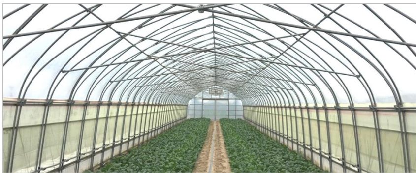
間口 5.4m、P径 25.4 mm、ピッチ 100 cm、トラス構造、X斜材補強
